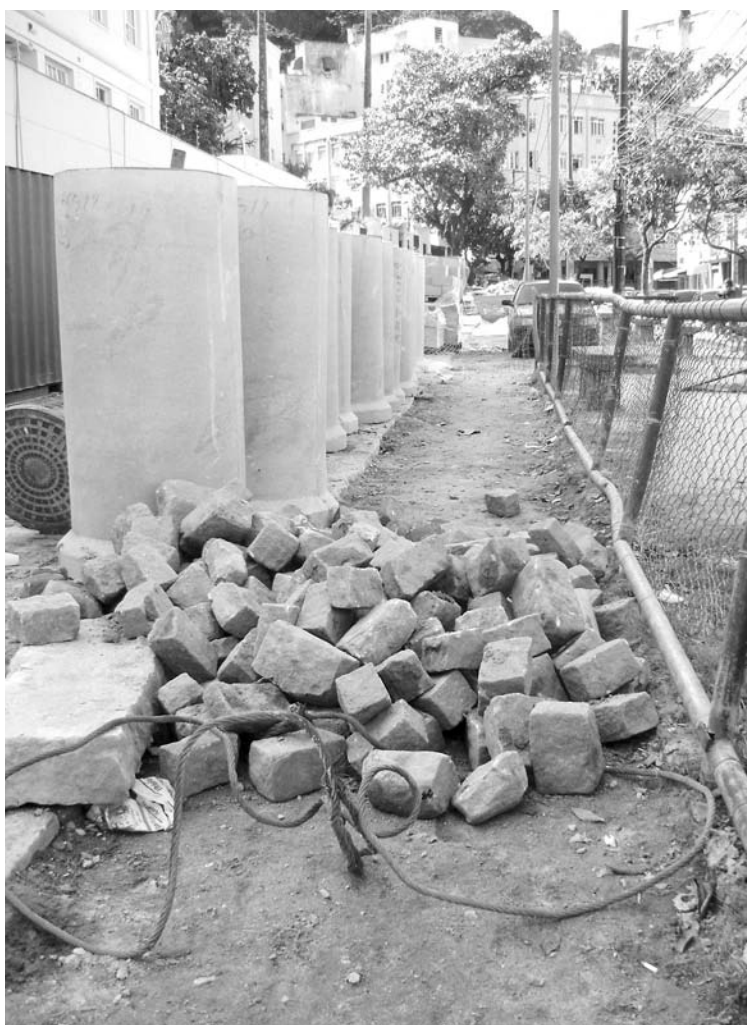
A RJZ transformou o largo num verdadeiro canteiro de obras
