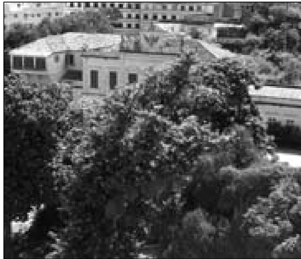
Prédio da administração da antiga Casa de Saúde Doutor Eiras que também será restaurado
