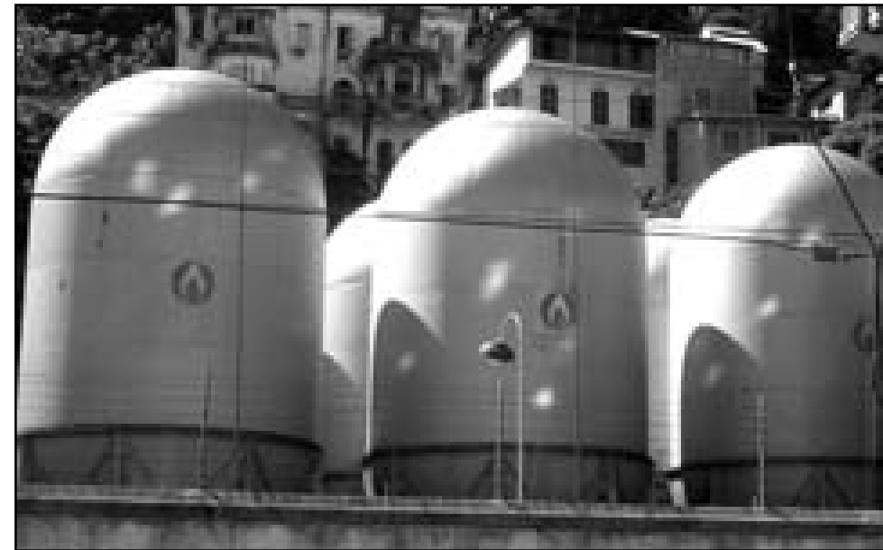
Construção é proibida devido a proximidade dos tanques de armazenamento de gás
