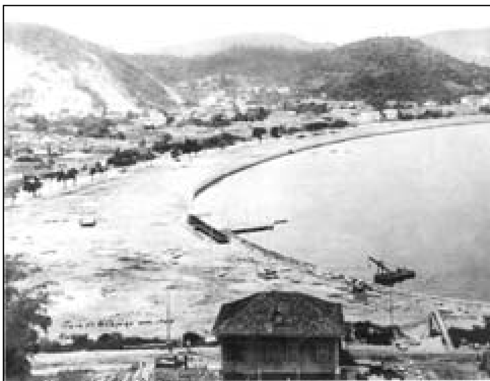
Praia de Botafogo - obra de alargamento em 1904 - foto Augusto Malta.
