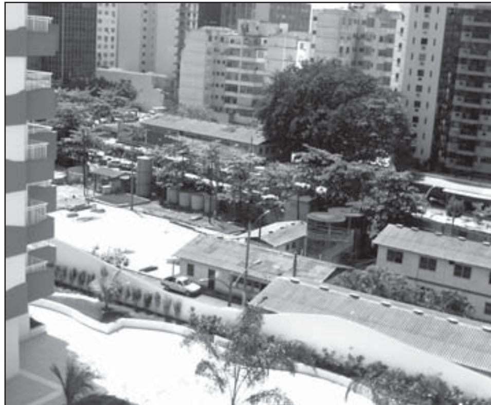
Canteiro de obras da Odebrecht na estação do metrô de Botafogo continua no local e ainda não existe qualquer sinal de construção da praça
